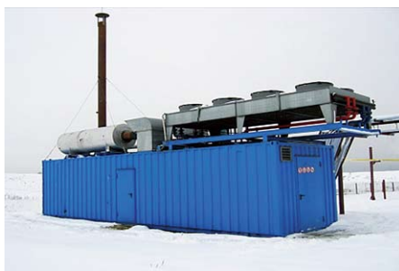
Шахта им. С.М. Кирова ОАО «СУЭК-Кузбасс», Россия КТЭС на устье скважины, пробуренной с поверхности
